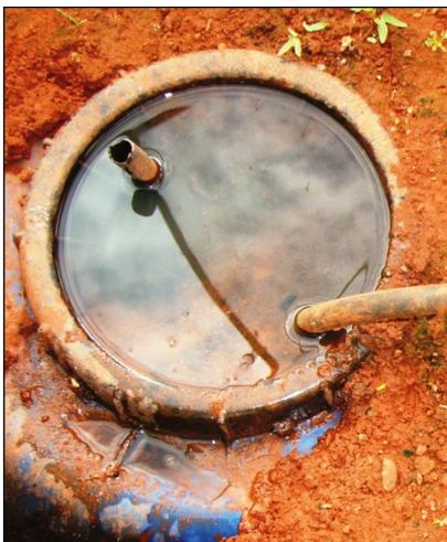
Figura 4 – Retorno de água às bombonas que funcionam como fossa séptica devido ao entupimento dos canos por gordura. As mangueiras vistas na foto servem para exalação e alívio de pressão por gases.
