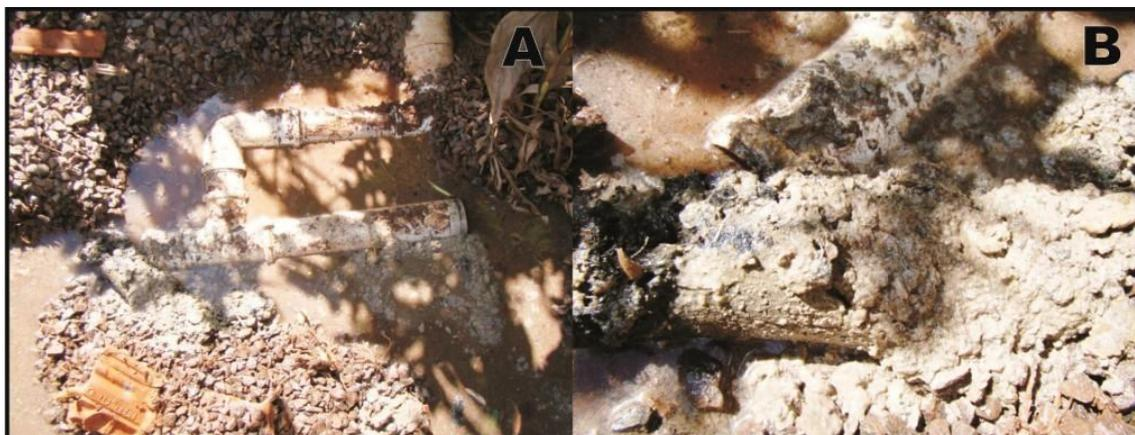
Figura 3 – Presença de gordura nos canos que dão vazão ao esgoto sobre a ETEZR's: A) visão geral dos canos de escoamento sobre a Estação; b) detalhamento das grossas crostas de gordura retiradas do interior do cano.
