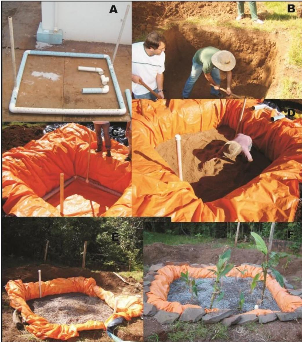
Figura 2 – Algumas etapas da montagem de uma ETEZR's: A) estrutura de canos de PVC para coleta de água; B) escavação de um buraco de 4m<sup>2</sup>x1m de profundidade; C) impermeabilização com lona plástica e colocação da estrutura coletora; D) preenchimento com areia ~50cm; E) cobertura com pedra ~50cm e F) estação em funcionamento com plantas.
